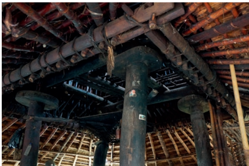
Cztery filary wspierające konstrukcję domu
