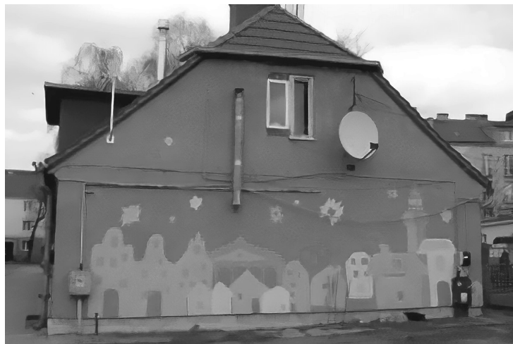
Dziecięcy mural na ścianie budynku przy ul. Floriańskiej
