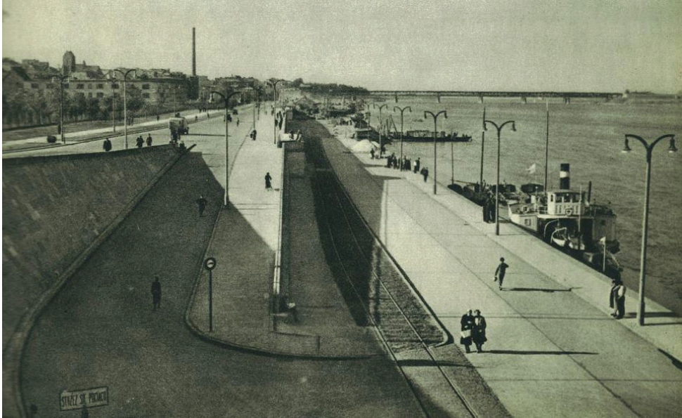
Il. 4. Wybrzeże Gdańskie, reprezentacyjny bulwar nad Wisłą. Widok z okolic mostu Kierbedzia (wysokość Zamku Królewskiego) w kierunku północnym (ku Cytadeli) około roku 1937. W dalekiej perspektywie widać trwające nadal prace budowlane (Warszawski modernizm).
