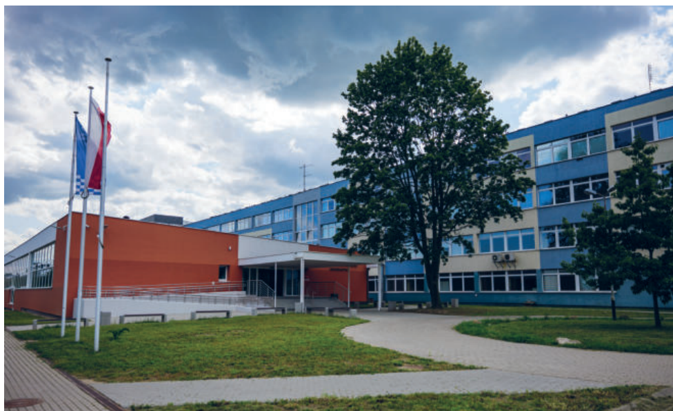
Fot. 4. Gmach Fizyki i Matematyki UG w Oliwie ul. Wita Stwosza 57, od 1975, obecny widok po remoncie generalnym budynku
