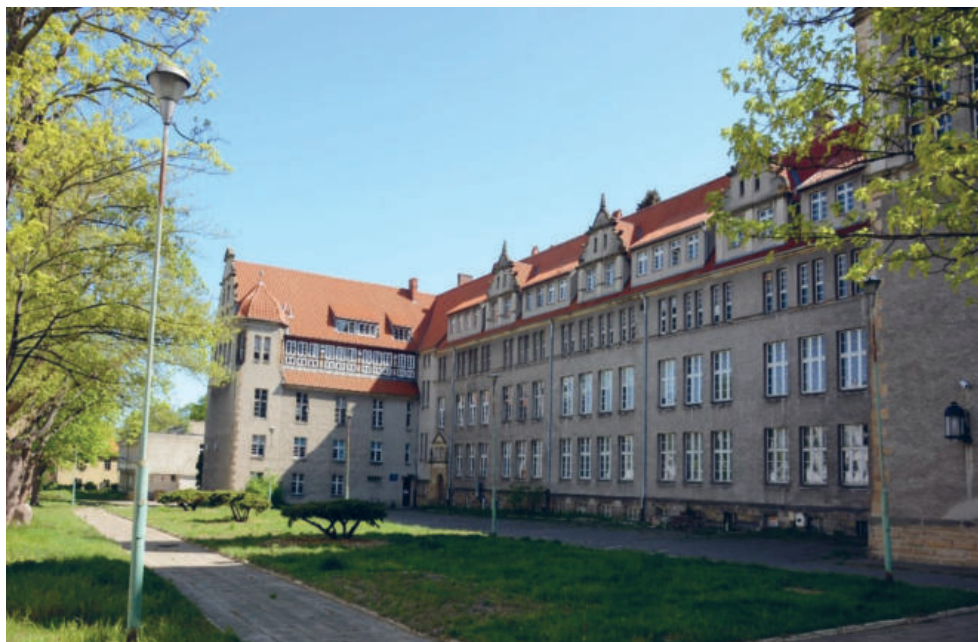
Fot. 5. Gmach Fizyki i Chemii UG (dawnego WSP) we Wrzeszczu, ul. Sobieskiego 18, 1970–1975; później tylko Wydziału Chemii UG
