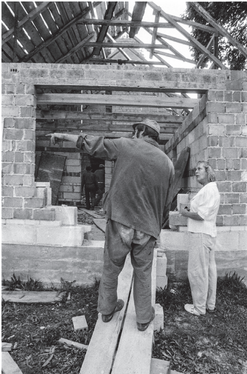
Beim Bau ihres Hauses, etwa 1992
