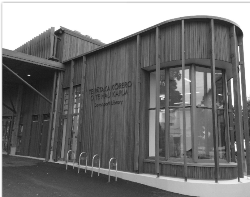
Fotografia 6. Biblioteka Devonport. Widok fasady
