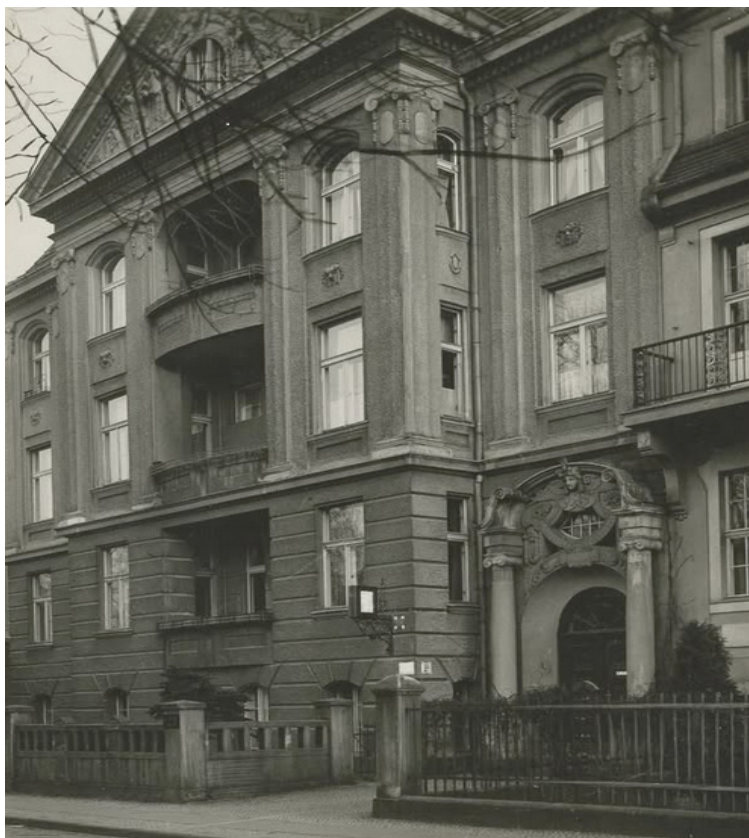
Fotografia 4. Budynek przy ul. Sienkiewicza 18 – siedziba Biblioteki Miejskiej w Słupsku od 1936 r.
