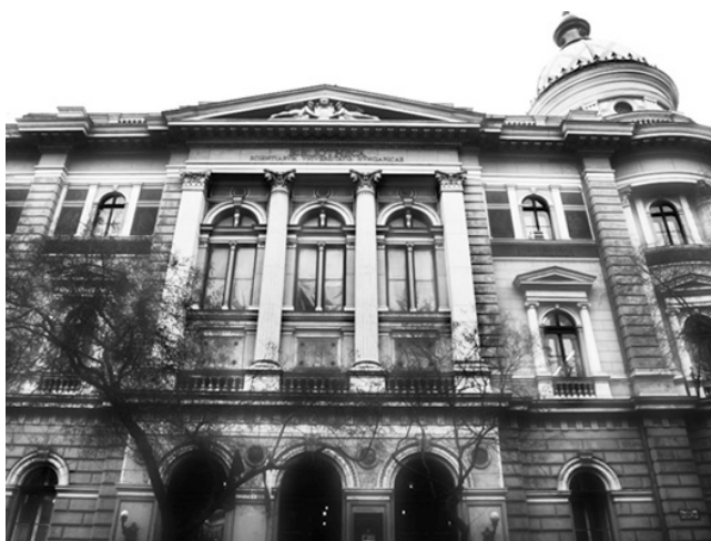
Fotografia 7. Fasada Biblioteki Uniwersyteckiej
