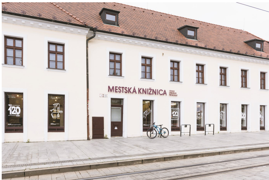
Fotografia 1. Budynek na ulicy Kapucínska
