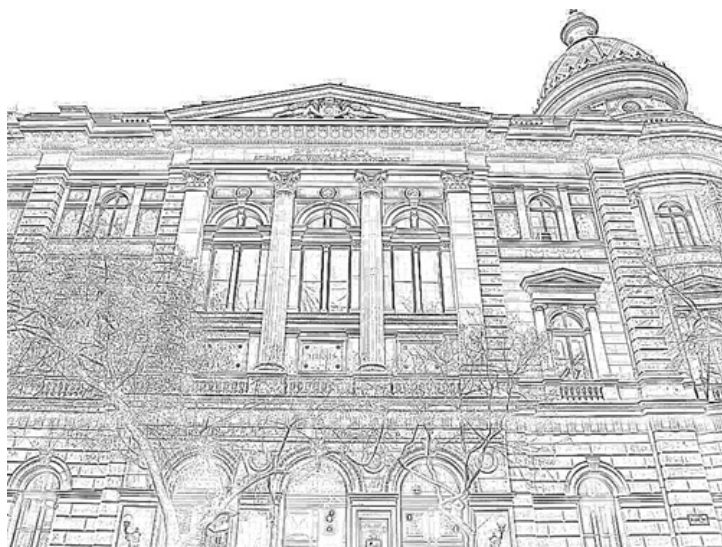
Fotografia 4. Fasada Biblioteki Uniwersyteckiej
