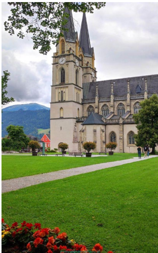
Fotografia 1. Opactwo w Admont. Widok na kościół
