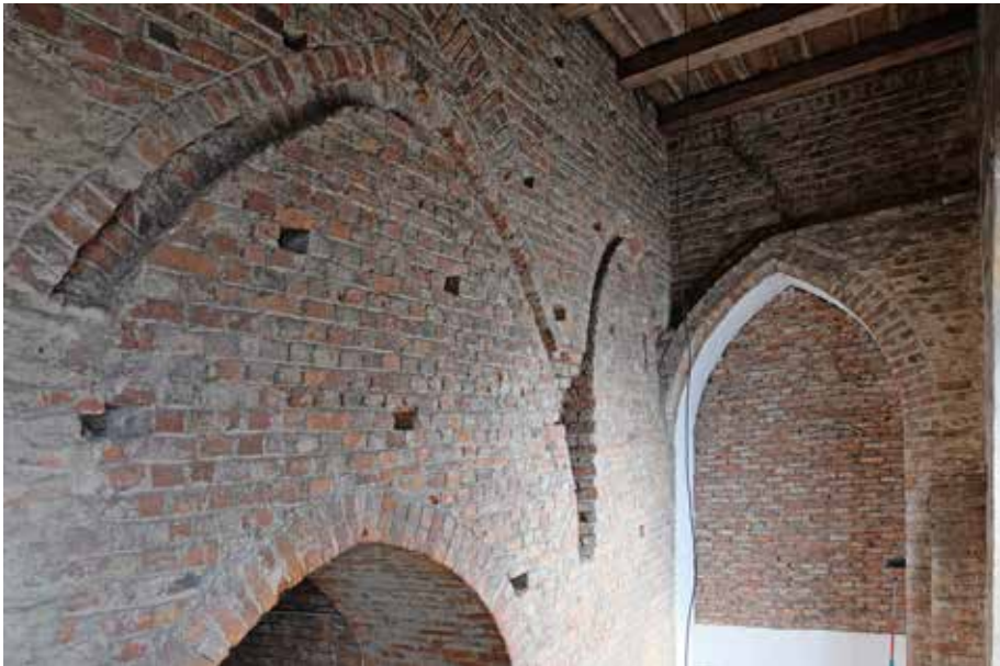
Abb. 14. Stargard, Johanniskirche, Gewölbeauflager an der Südwand des Turmschafts im Bereich des südlichen Turmanbaus, Turmschaft nach 1408, Gewölbeauflager und südlicher Turmanbau 1819, Foto: Marek Fiedorowicz
