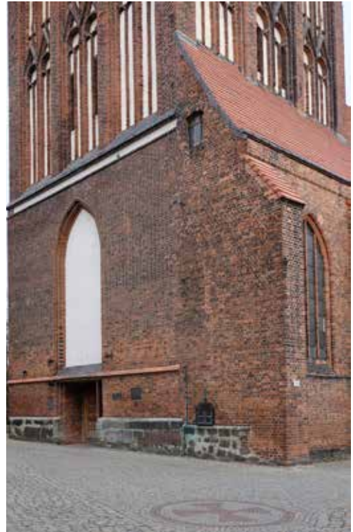
Abb. 15. Stargard, Johanniskirche, Erdgeschoss des Westturms (nach 1408) und südlicher Turmanbau (1819), Foto: Marek Fiedorowicz
