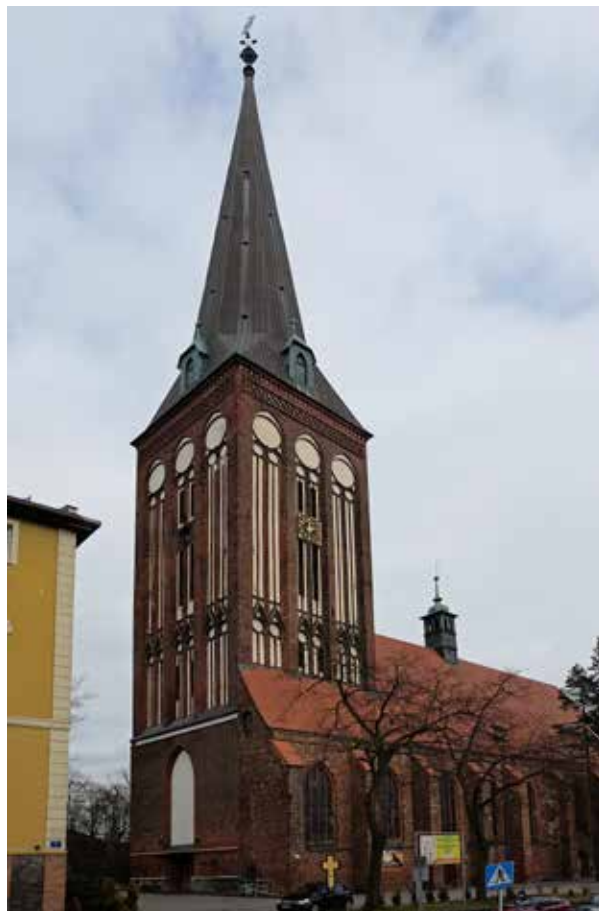
Abb. 1. Stargard, Johanniskirche, Ansicht von Südwesten. Chor und Langhaus 1330er Jahre – um 1350, Westturm 1408 – um 1464, Foto: Marek Fiedorowicz
