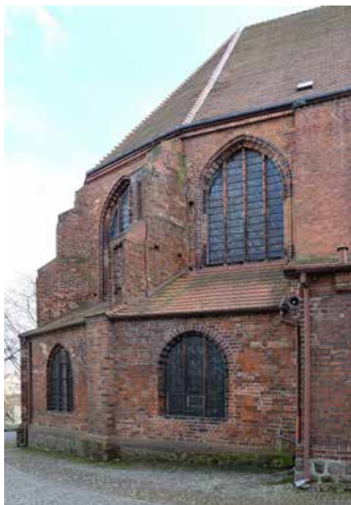
Abb. 10. Stargard, Johanniskirche, Chorungang mit niedrigem Kapellenkranz, Blick von Norden, Chorungang vor 1450, Kapellenkranz um 1500, Foto: Marek Fiedorowicz
