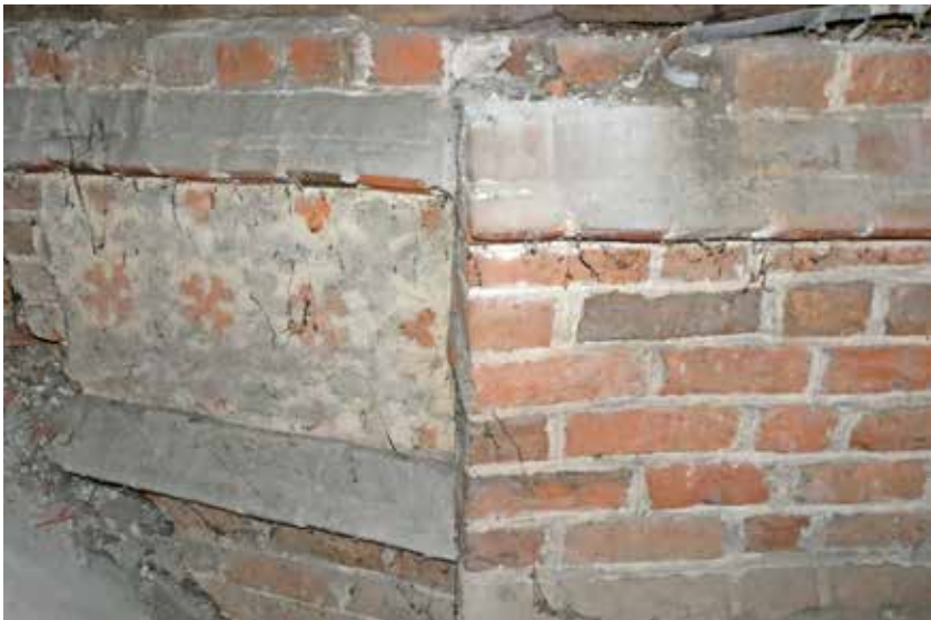
Abb. 18. Stargard, Johanniskirche, Überreste der Umfassungsmauern des alten polygonalen Chorschlusses mit einem abgetrepten Strebepfeiler (rechts), vor 1397, Foto: Marek Fiedorowicz
