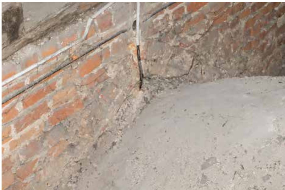
Abb. 19. Stargard, Johanniskirche, Überreste der alten Chorfenster (2. Viertel d. 14. Jhs.) über den Gewölbekappen des heutigen Binnenchores (vor 1450), Foto: Marek Fiedorowicz
