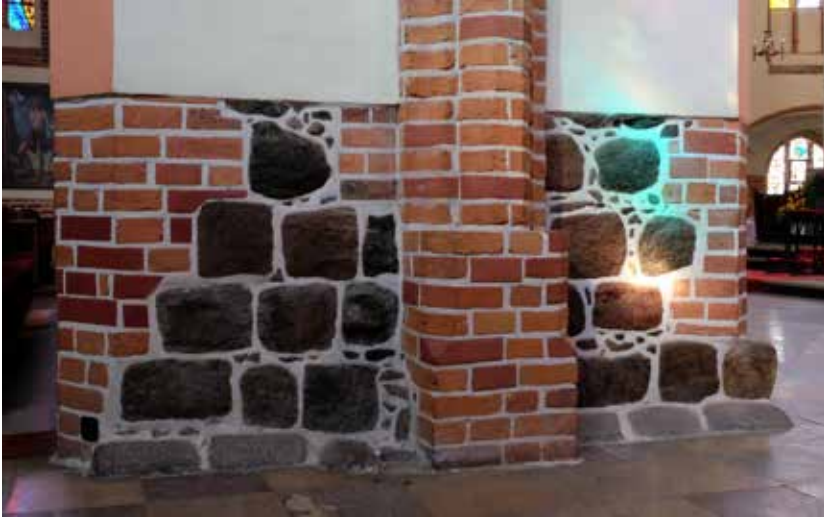
Abb. 4. Stargard, Johanniskirche, Granitquader im unteren Bereich der Chorpfeiler, 2. Hälfte 13. Jh.; mittig Überreste eines Strebepfeilers des alten eingezogenen Chores aus dem 2. Viertel d. 14. Jhs., Foto: Marek Fiedorowicz
