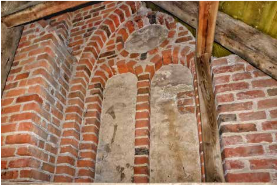
Abb. 11. Stargard, Johanniskirche, Blendendekor an dem im Dachbodenbereich verborgenen Langhausostgiebel mit Spuren von Malereien, vor 1350, Foto: Marek Fiedorowicz
