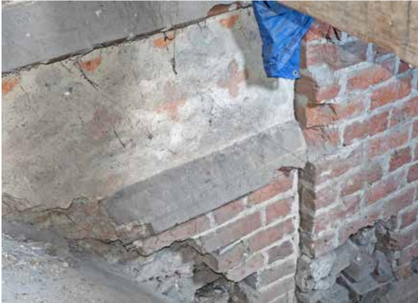
Abb. 17. Stargard, Johanniskirche, Überreste der Umfassungsmauern des alten eingezogenen Chores über den Umgangsgewölben mit deutlicher Stoßfuge an der Nahtstelle zwischen Längswand (rechts; 2. Viertel d. 14. Jhs.) und angebautem polygonalem Chorschluss mit farbigem Putzfries (links; vor 1397), Foto: Marek Fiedorowicz
