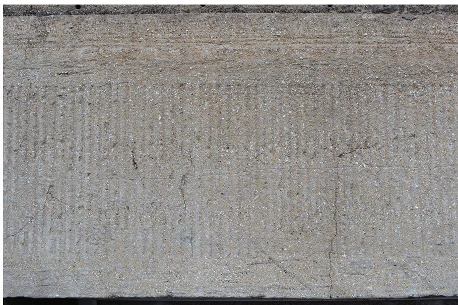
Il. 5. Tynk z obróbką kamieniarską, fot. Weronika Stasińska
