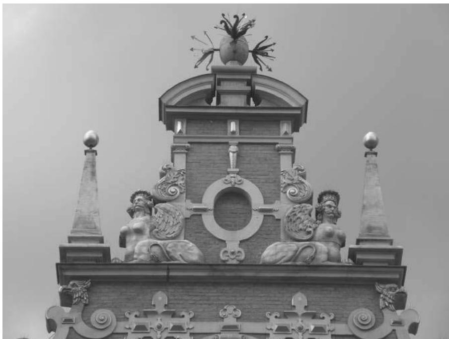
Il. 9. Abraham van den Blocke z warsztatem, fragment szczytu wschodniej fasady Wielkiej Zbrojowni, Gdańsk, 1605–1606, piaskowiec gotlandzki, częściowa rekonstrukcja po 1945, fot. Franciszek Skibiński
