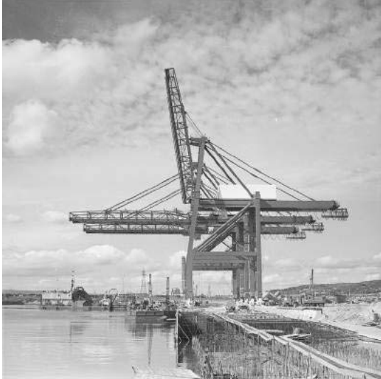
Il. 22. Halina Wasielke-Cieślak, Budowa bazy kontenerowej w Gdyni 1976–1978 , Muzeum Miasta Gdyni, sygn. MMG/HM/II/666
