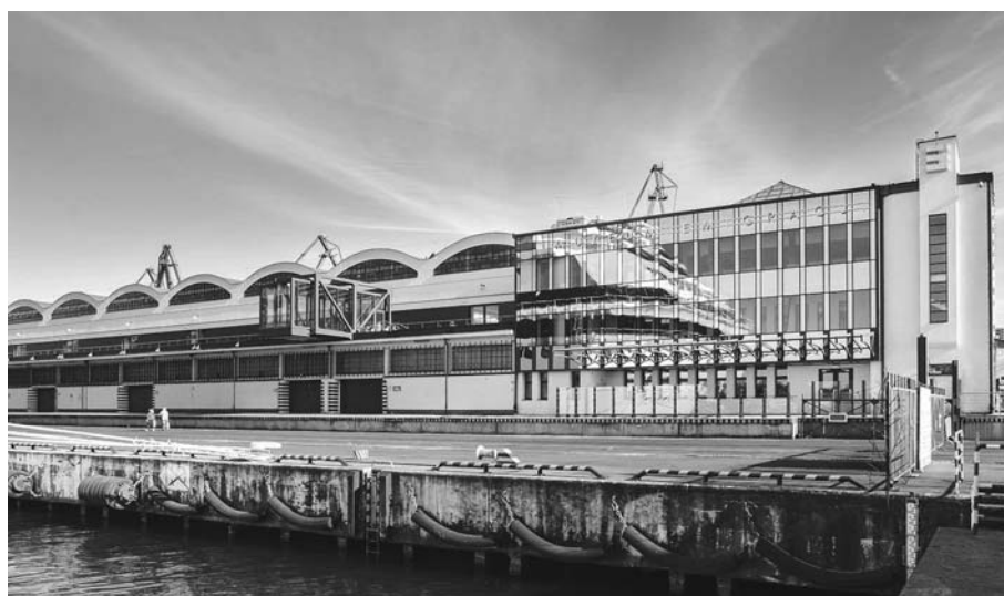
Il. 12. Północna elewacja Hali Pasażerskiej po przebudowie, 2015 r., Muzeum Emigracji w Gdyni, fot. Bogna Kociumbas
