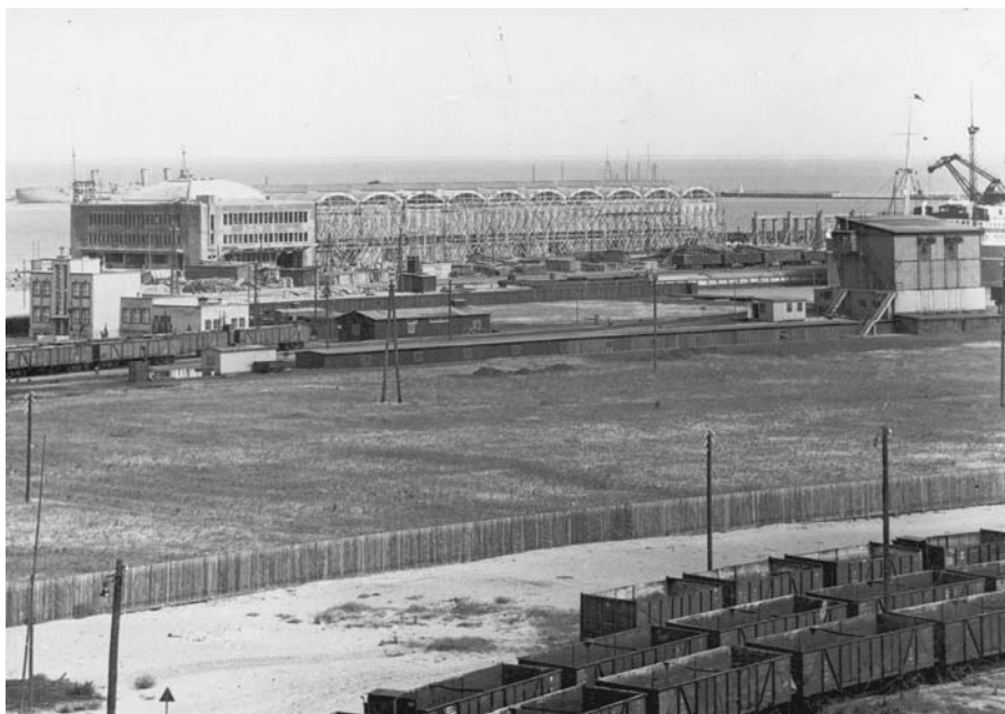
Il. 2. Budowa Dworca Morskiego w Gdyni, 1933, Narodowe Archiwum Cyfrowe
