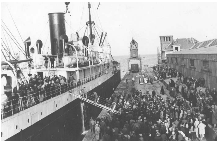
Il. 1. Zaokrętowanie na Nabrzeżu Pilotowym w Gdyni – po prawej stronie fragment Magazynu nr 1, początek lat trzydziestych XX w., Narodowe Archiwum Cyfrowe
