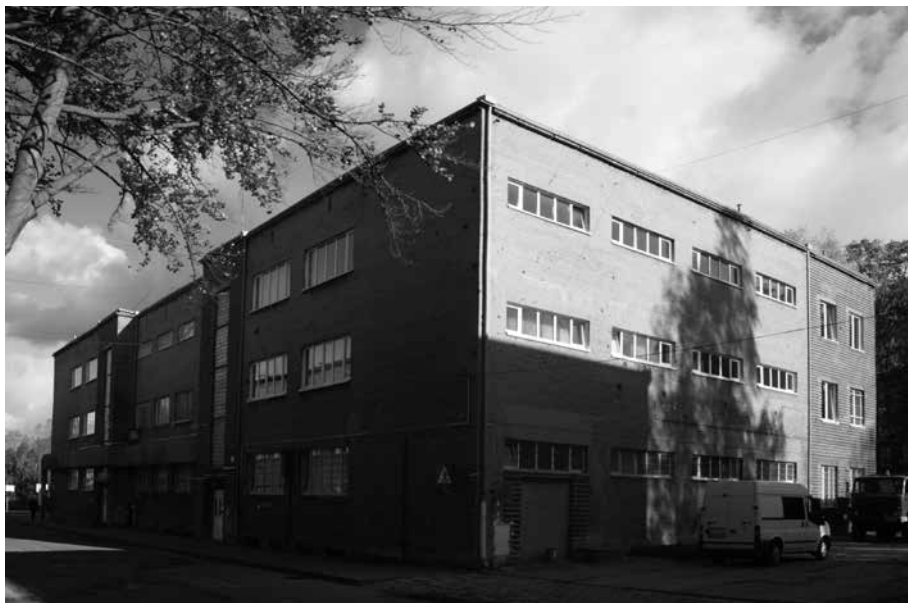
Il. 6. Gdynia, Obóz Emigracyjny, budynek dezynfekcyjno-kąpielowy, elewacja zachodnia i południowa, fot. Anna Posłuszna
