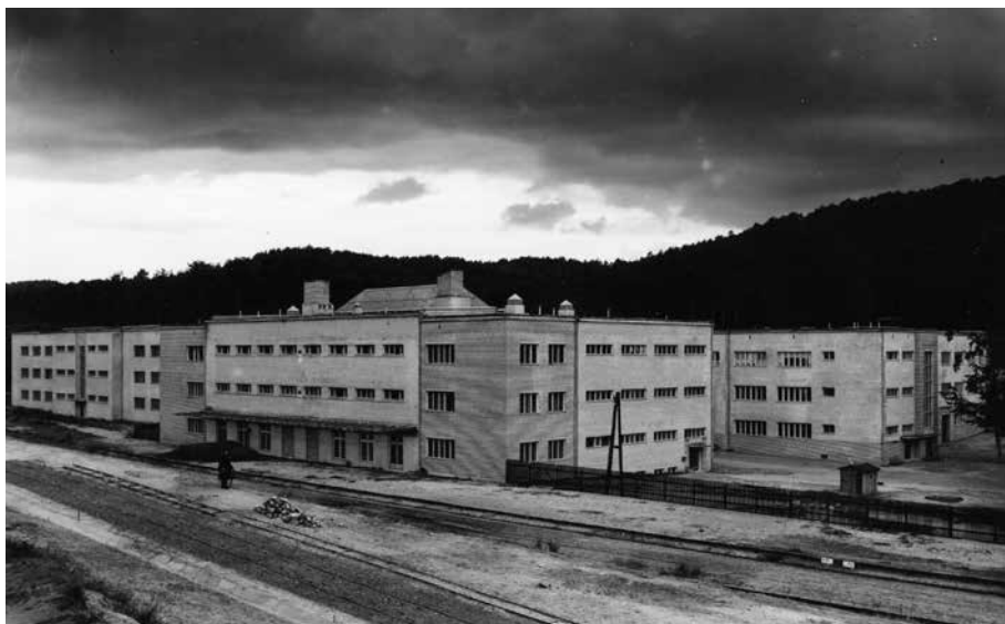
Il. 1. Gdynia, Obóz Emigracyjny, budynek dezynfekcyjno-kąpielowy, elewacja północna i wschodnia, lata trzydzieste XX w., fot. Muzeum Miasta Gdyni
