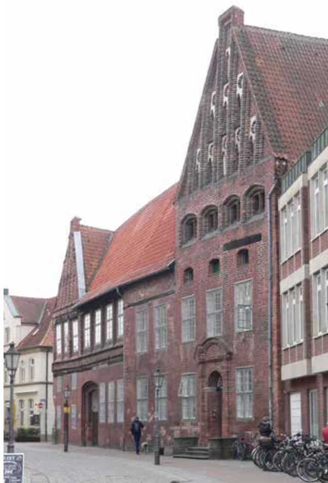
Abb. 6. Wohnhaus von Stephan Loitz in Lüneburg An der Münze 7, mit Giebeln aus der 2. Hälfte des 15. Jahrhunderts und späteren Umbauten unter David Braunschweig 1597, Foto: Bettina Schröder-Bornkamp
