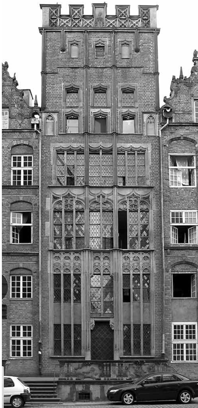
Il. 16. Fasada domu gotyckiego przy ul. Chlebnickiej 14 w Gdańsku po rekonstrukcji przeprowadzonej w latach siedemdziesiątych XX w. wg projektu Kazimierza Orłowskiego. Fot. Małgorzata Omilanowska
