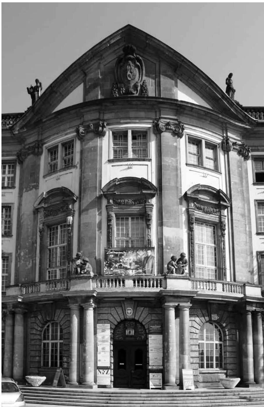
Il. 9. Ryzalit fasady gmachu Dyrekcji Kolei w Gdańsku. Fot. Katarzyna Wojtczak
