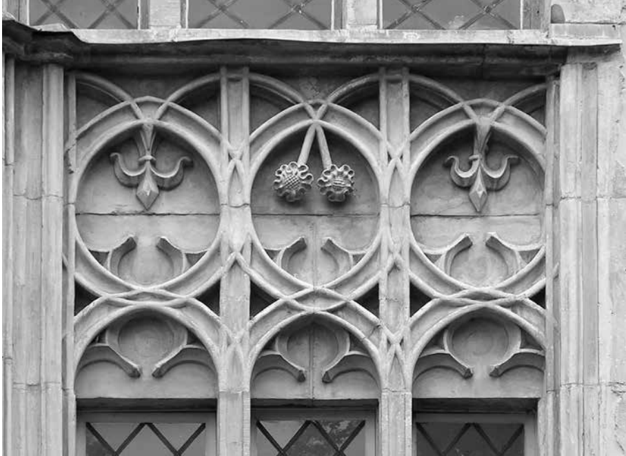
Il. 6. Maswerki między pierwszą i drugą kondygnacją fasady domu gotyckiego na Wyspie Pawiej w Poznaniu.
