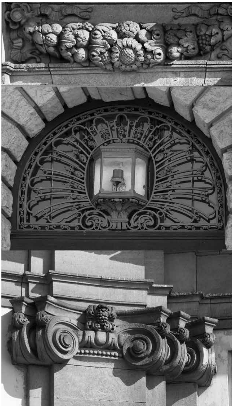
Il. 10. Detale fasady gmachu Dyrekcji Kolei w Gdańsku. Fot. Katarzyna Wojtczak
