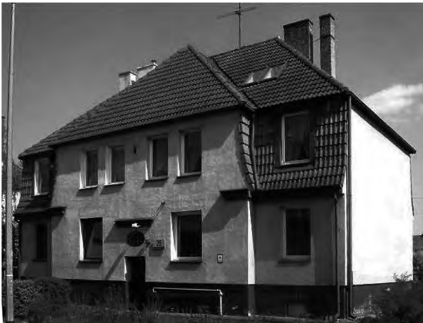
Il. 20. Dom przy obecnej Klonowicza 25, widok elewacji zachodniej, fot. Jagoda Załęska-Kaczko
