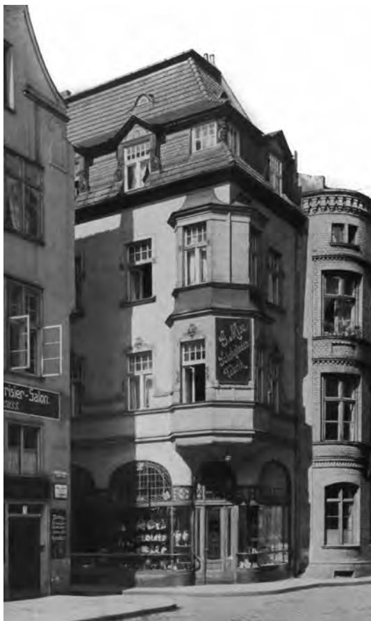
Il. 5. Kamienica przy ulicy Św. Ducha 7, wg Ernst Schade, ( Bauten von Reg.- baumeister Schade...
