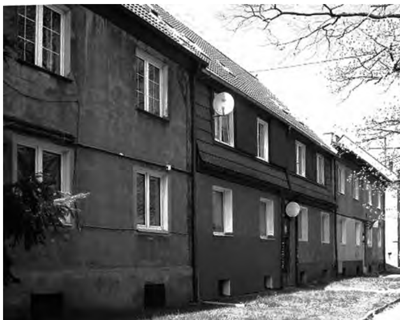
Il. 15. Dom przy obecnej Klonowicza 4/6/8, widok elewacji wschodniej, fot. Jagoda Załęska-Kaczko
