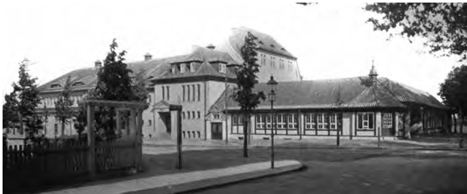
Il. 21. Budynek hali sportowej przy al. Zwycięstwa 15. Widok od zachodu, wg Ernst Schade, (Bauten von) Reg.- baumeister Schade...
