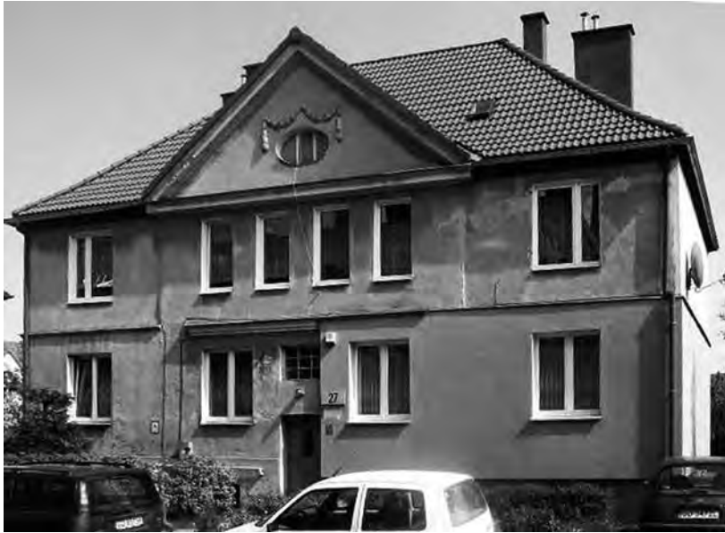
Il. 19. Dom przy obecnej Klonowicza 27, widok elewacji zachodniej, fot. Jagoda Załęska-Kaczko
