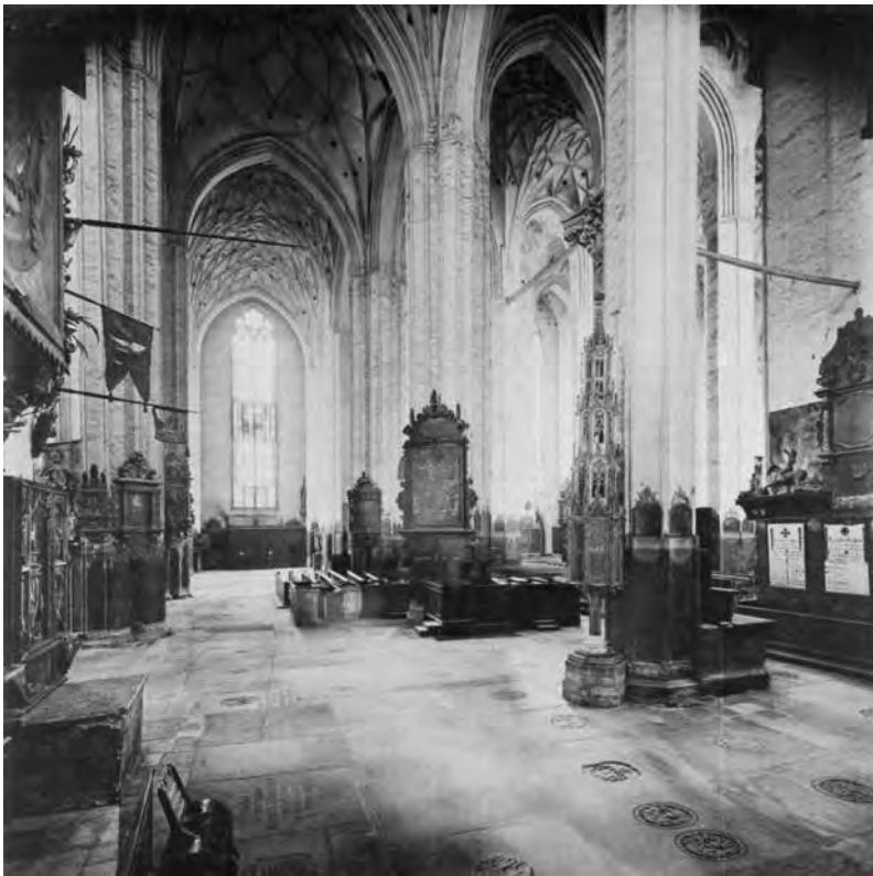
Il. 4. Gdańsk, kościół Mariacki, widok filara św. Jerzego od strony pld.-wsch., przed 1945, Bildarchiv Foto Marburg
