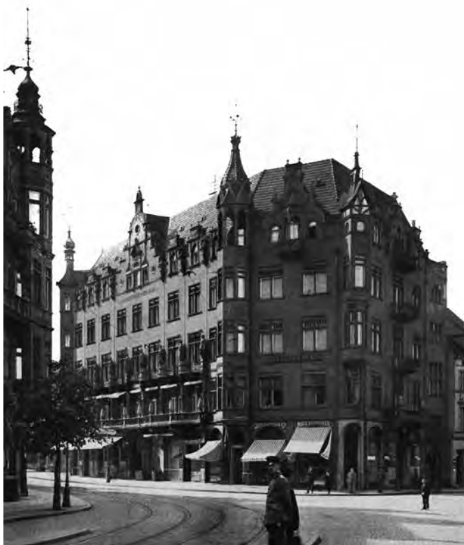
Il. 3. Kamienica przy Targu Drzewnym 12/14, widok od strony Targu Drzewnego, wg Ernst Schade, ( Bauten von ) Reg.- baumeister Schade...
