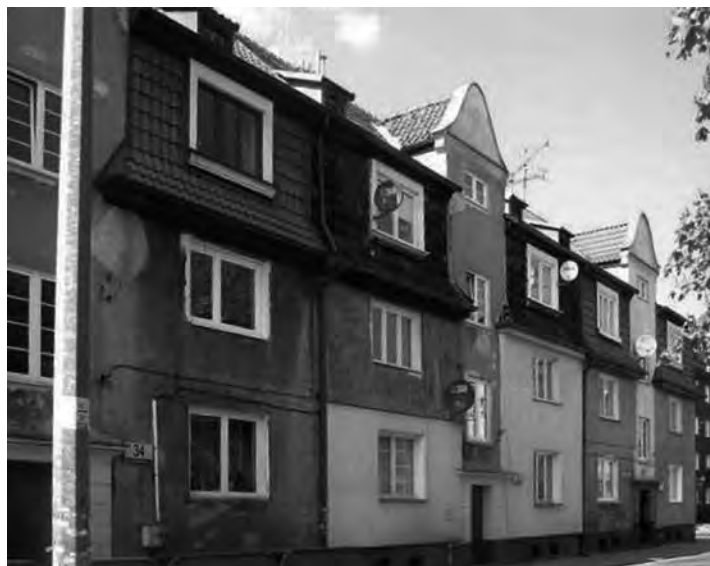
Il. 26. Dom przy obecnej Klonowicza 34/36/38, widok elewacji wschodniej, fot. Jagoda Załęska-Kaczko
