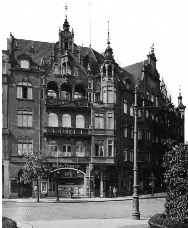
Il. 2. Kamienica przy Targu Drzewnym 15/16, widok od strony Targu Drzewnego, wg Ernst Schade, ( Bauten von ) Reg.-baumeister Schade...
