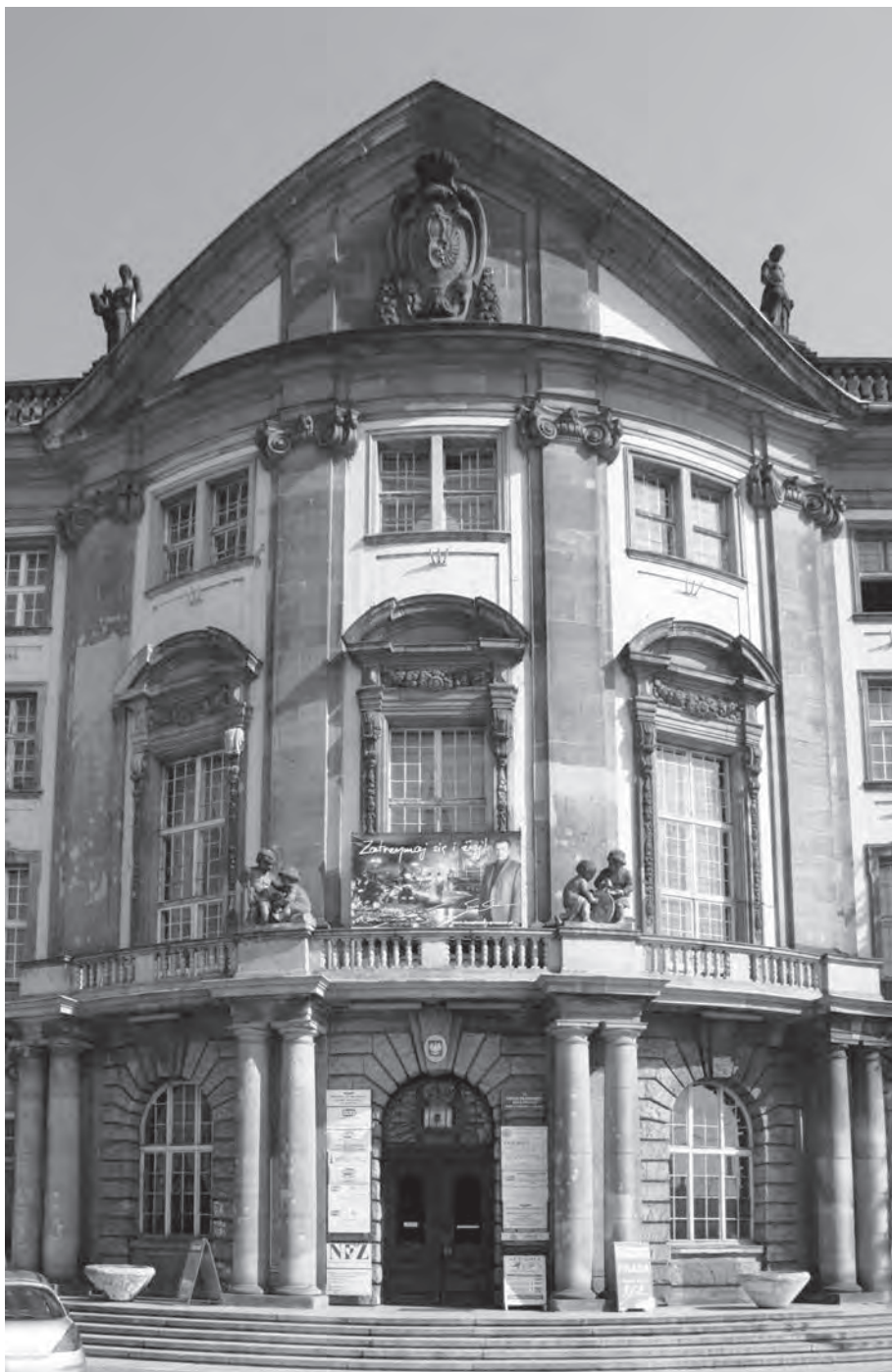
Il. 9. Ryzalit fasady gmachu Dyrekcji Kolei w Gdańsku. Fot. K. Wojtczak
