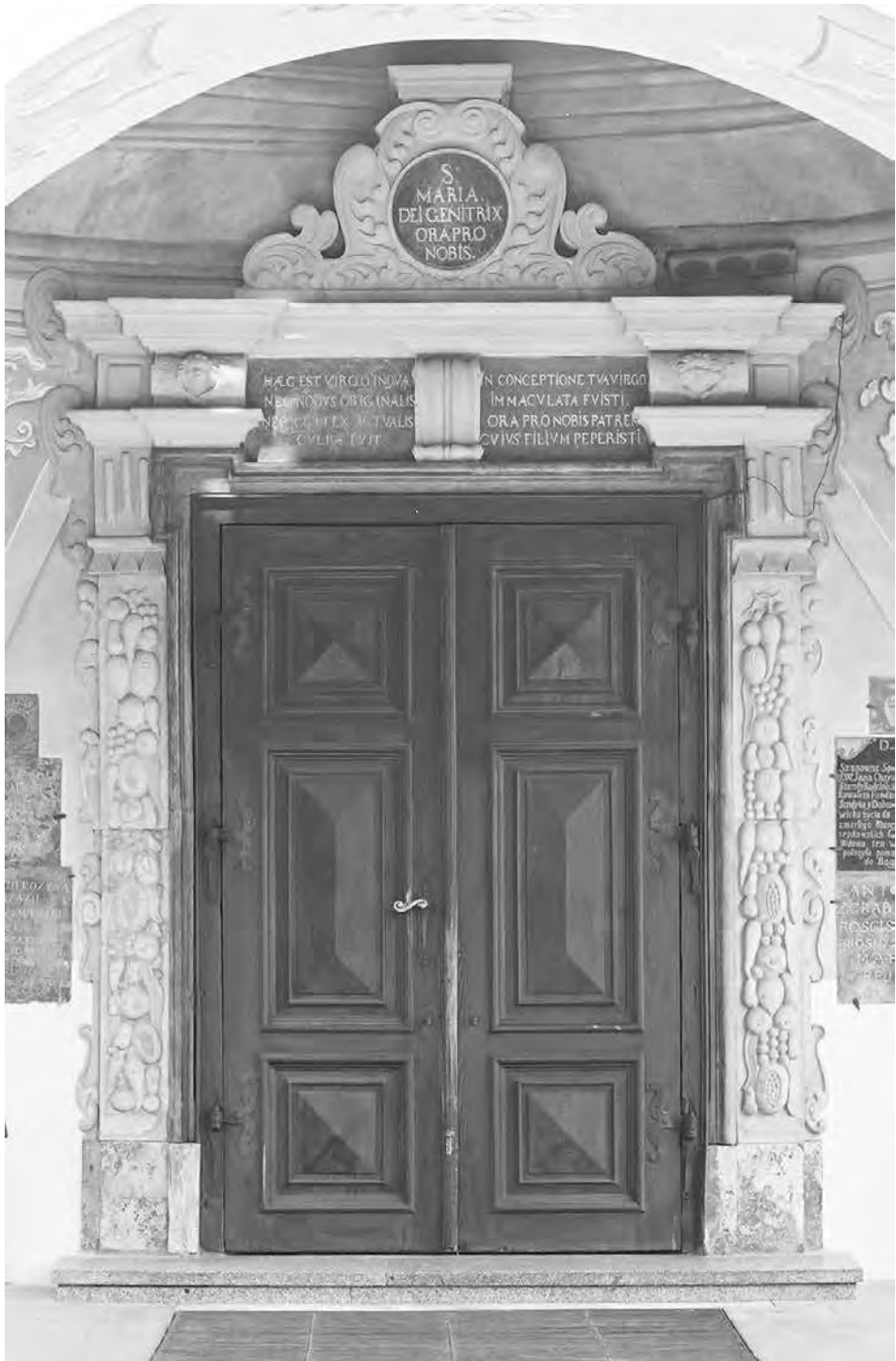
Il. 27. Portal południowy kościoła bernardynów w Leżajsku, warsztat elbląski (?), około 1670 r., piaskowiec gotlandzki Burgsvik , wapień olandzki (warstwa czerwona), fot. M. Wardzyński
