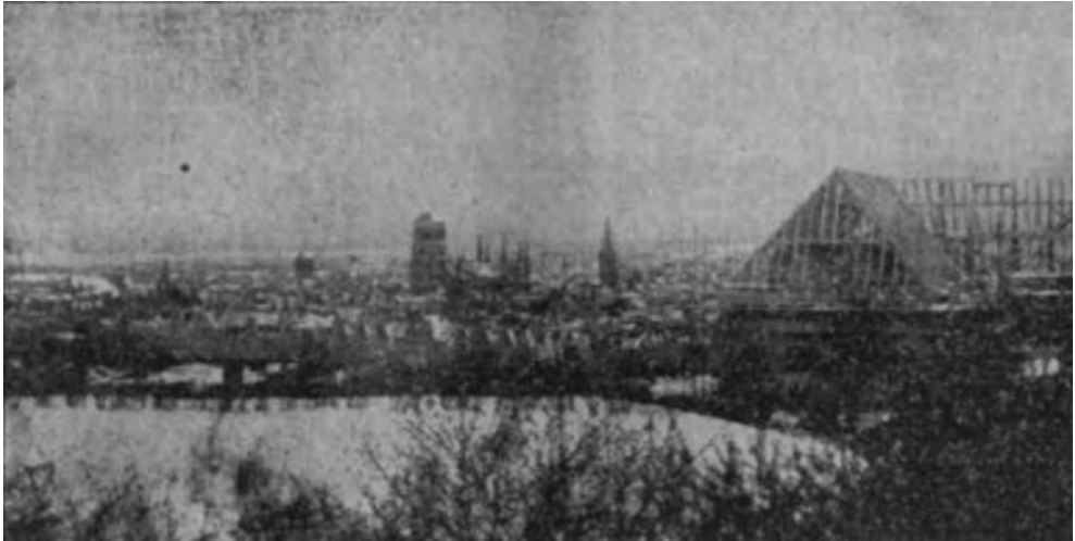
2. Budowa schroniska. Stan z marca 1939 r., źródło: „Der Danziger Vorposten”, 68, 21.03.1939, s. 13
