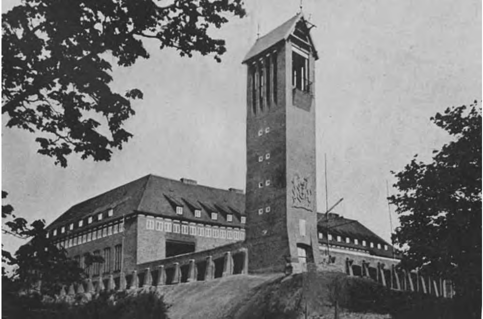
1. Widok schroniska od strony południowo-zachodniej, źródło: „Die Möwe”, 13, 25.08.1940
