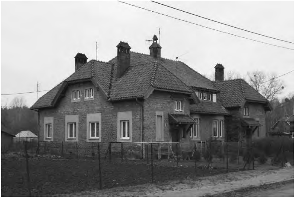
3. Kadyny, budynek mieszkalny, 1900, stan obecny
