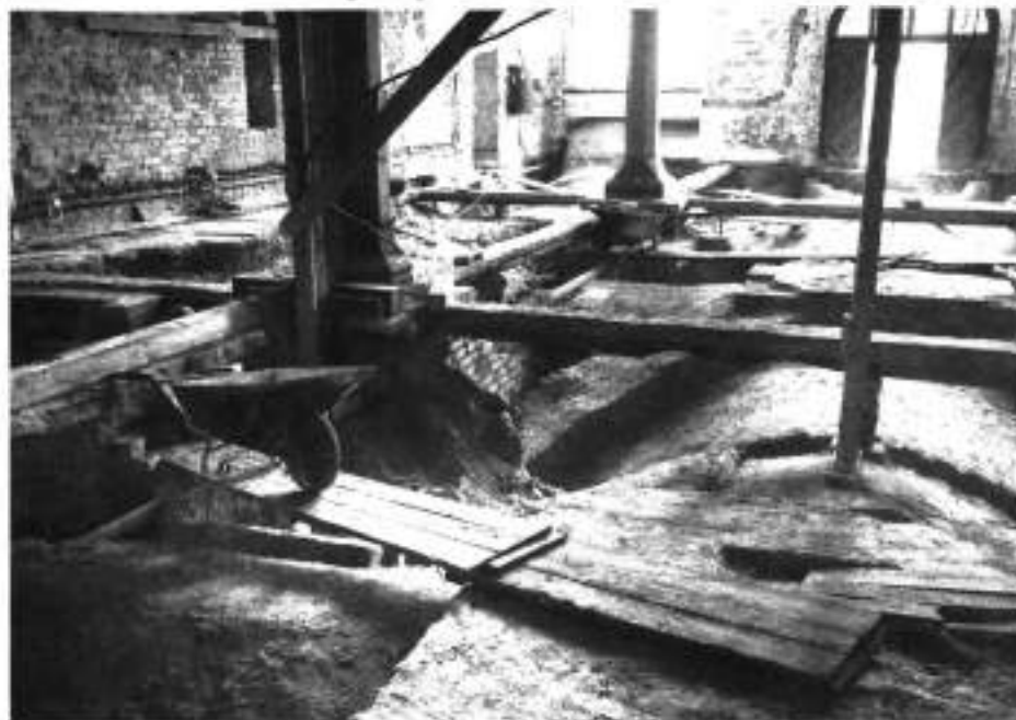
11. Odsłonięte sklepienie piwnic widoczne z hali Dworu Artusa, 1987 r.
