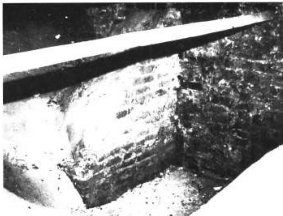
9. Przyziemie. Ściana południowa. Obudowa przewodu wentylacyjnego. Po prawej stronie skuty pas lica ściany
