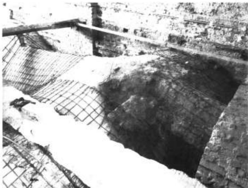
12. Zbrojenie koszulek żelbetowych wzmacniających sklepienie Dworu Artusa
