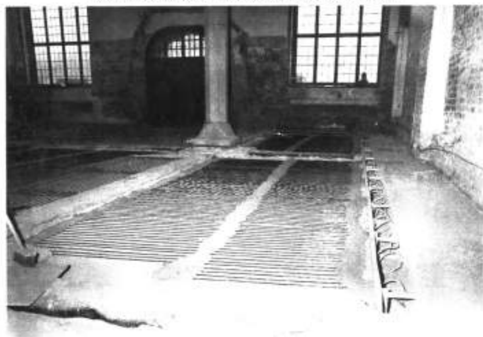
13. Instalacje elektryczno-ogrzewcze w posiadce Dworu Artusa
