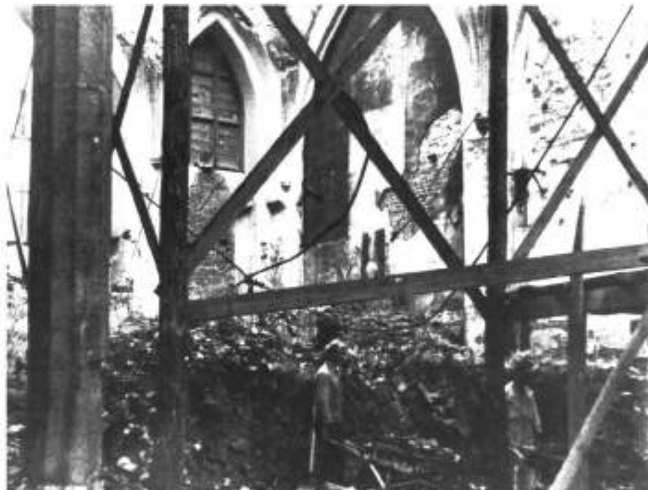
3. Wnętrze Dworu Artusa po wojnie. Prace przy odgruzowaniu, 1948 r.
