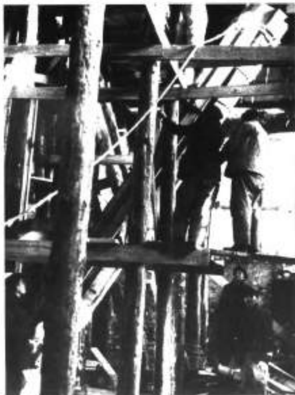
4. Montaż nowych filarów, 1950 r.
