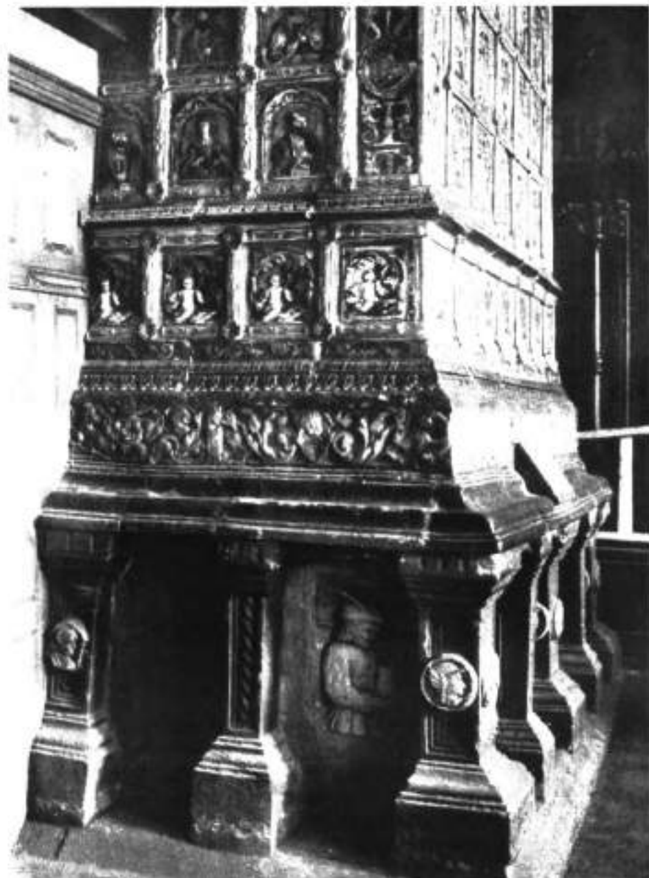
W przedmnie odbudowy pieca w Dworze Artusa w Gdańsku
