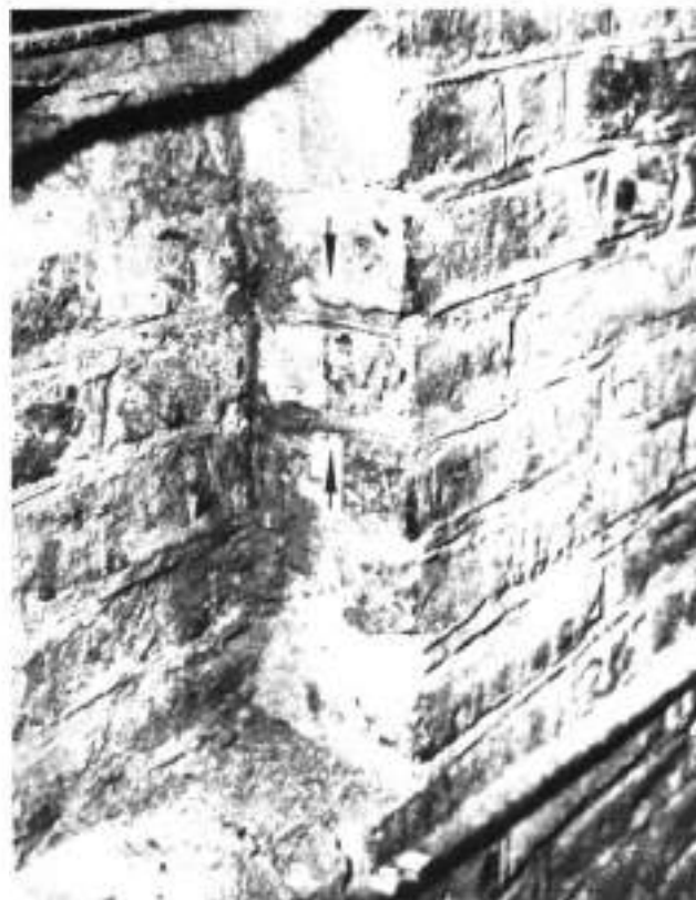
11. Cegła z fragmentem polichromii wbudowana w mur ściany wschodniej, poniżej posadzki.
