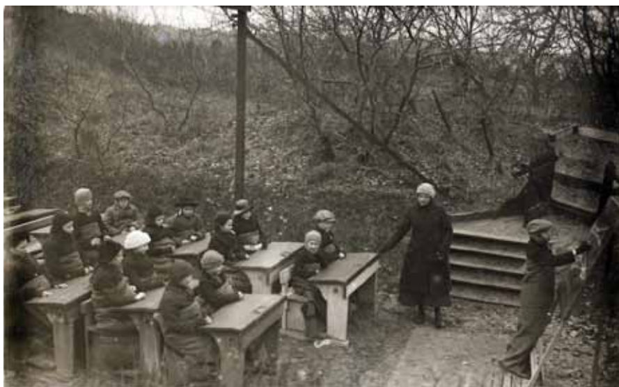
Fot. 1. Przykład radykalnego zastosowania idei Open-Air – szkoła na otwartym powietrzu w Holandii 1 , 1918 rok
