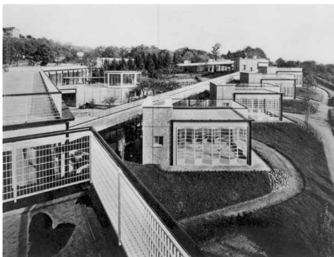
Fot. 10. Szkoła Open-Air w Suresnes, widok na założenie z balkonu, widoczne dwa poziomy komunikacji – tarasy nad pawilonami połączone były estakadą pieszą, z której roztaczał się widok na cały obszar szkoły
