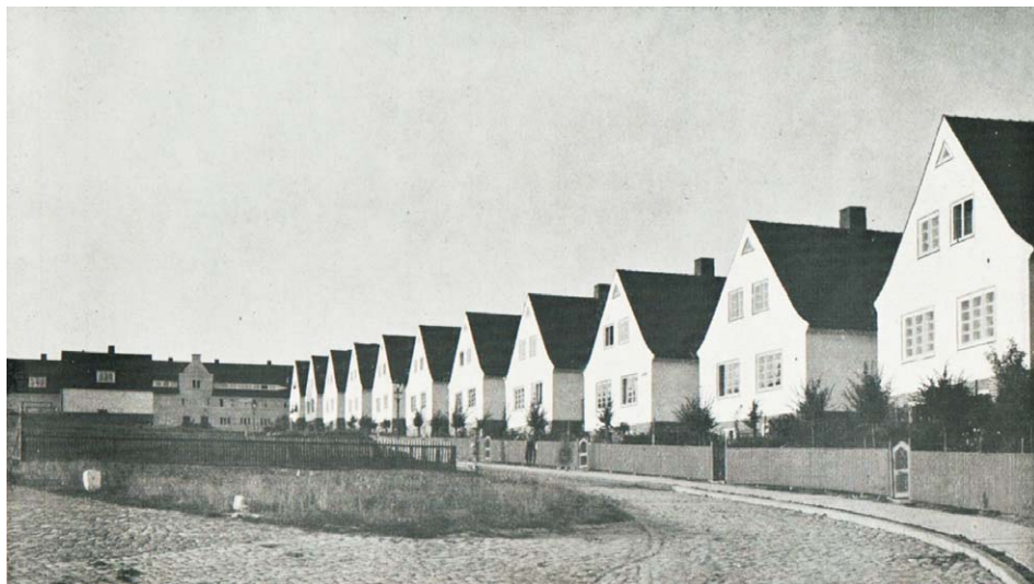
Il. 3. Domy jednorodzinne, wybudowane przy ulicy Wyczółkowskiego ( Kleine Molde ). Źródło: H. Althoff, Siedlungsarbeit in der Freien Stadt Danzig 1920–1930 , Danzig 1930
