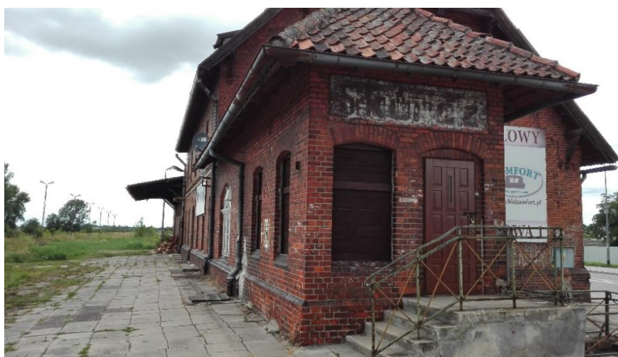
Ryc. 15. Nieczynny dworzec kolejowy w Skórczu
