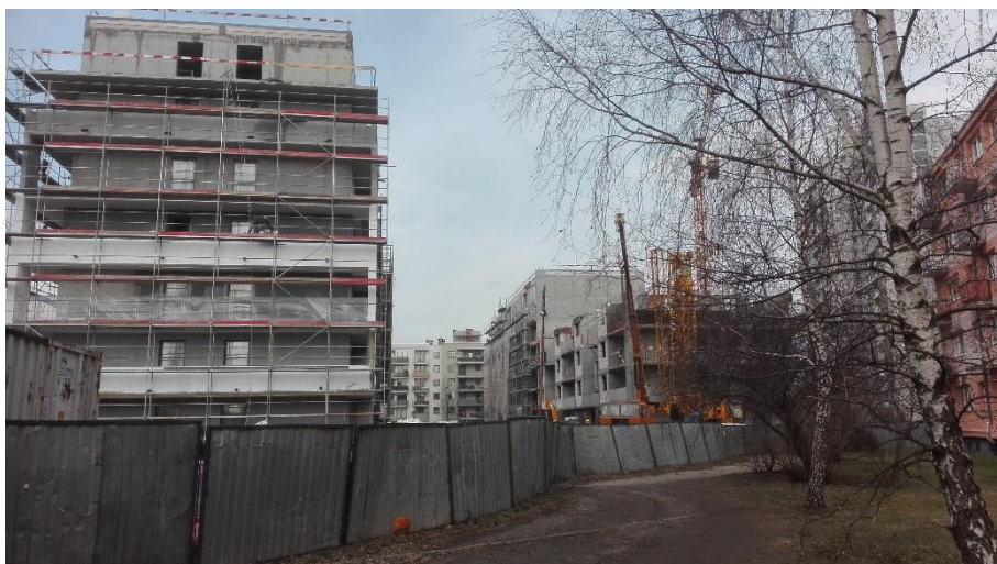
Ryc. 13. Budowa nowych bloków mieszkalnych w Gdańsku Przymorzu
