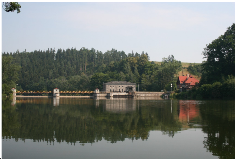
Ryc. 6. Elektrownia wodna Wrzeszczyn na Jeziorze Wrzeszczyńskim (fot. Paweł Kuźniar [2])
