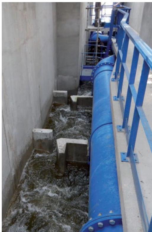
Ryc. 8. Przepławka na stopniu wodnym we Włocławku (Dębowski, 2016)
