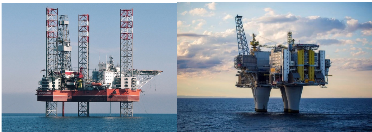
Ryc. 1. – a - przykład mobilnej platformy wydobywczej typu jack-up [2], b - platforma na stałe osadzona na betonowych fundamentach [3]
