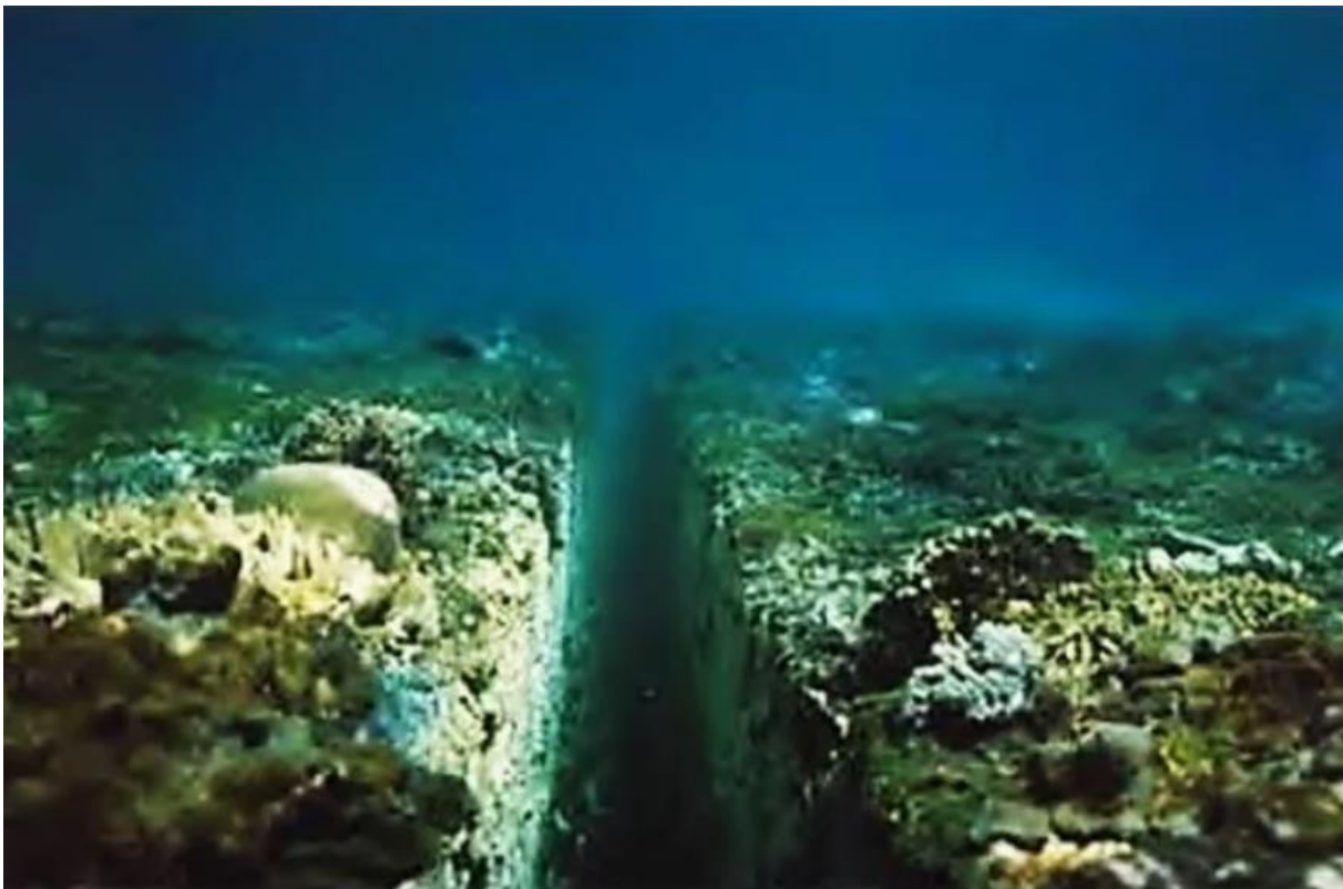
Ryc.4. Rów wykopany pod kabel [3]
